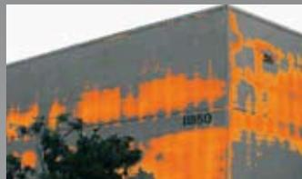
Thermal Fusion Bild, das Temperaturunterschiede zeigt. Dies ist ein Anzeichen für bauliche Mängel in der Gebäudehülle.
